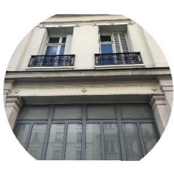
Linteaux : 16 unités 3 tonnes
