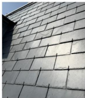
Ardoises à réemployer IN-SITU.
