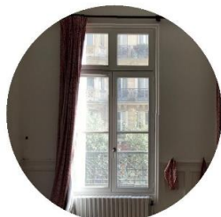
Fenêtre bois double vitrage : 86 unités 8,5 tonnes.
