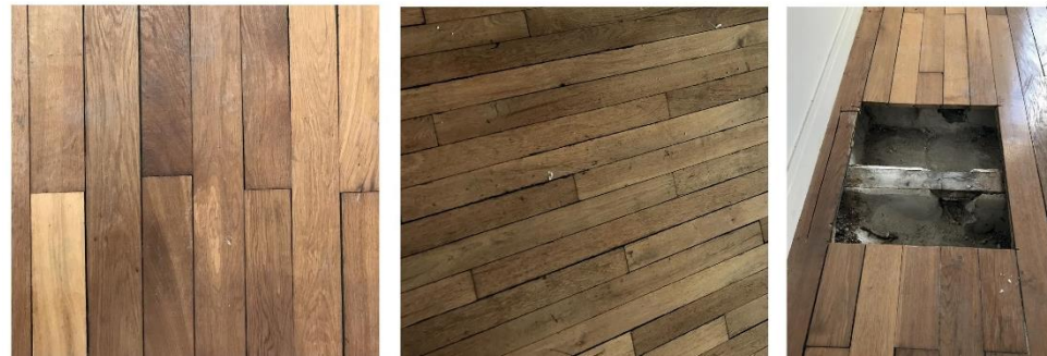
Lames de parquet en chêne et lambourdes à réemployer IN-SITU. Source : REAP by AREP
