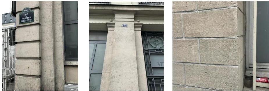
Chaines d'angles et pierres de façade à réemployer IN-SITU. Source : REAP by AREP
