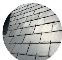
Ardoises 30m 2 66 tonnes
