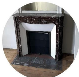
Cheminée : 23 unités dont dalles foyères 40m 2 de marbre soit 2,3 tonnes
