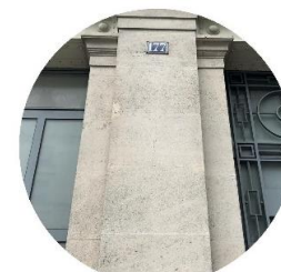
Pierre calcaire de colonne 45 unités, 18m 3 31 tonnes
