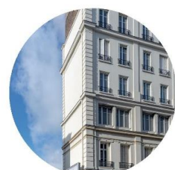
Pierre calcaire des colonnes supérieures 66 unités, 17 m 3 26 tonnes
