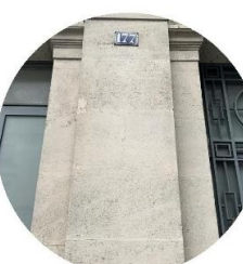
Pierre calcaire de colonne (5): 45 unités, 18 m 3 31 tonnes
